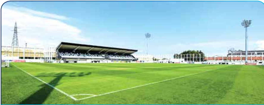
Abbildung 51. Beispiel für eine Flutlichtanlage (International)
